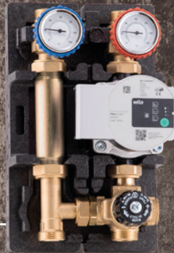
02G.DN20: Gruppo di regolazione con valvola miscelatrice termostatica
